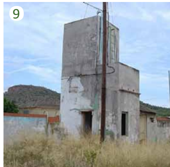
7. Partidor de Torres Torres 8. Desagüe 9. Pozo y balsa de Falcó
